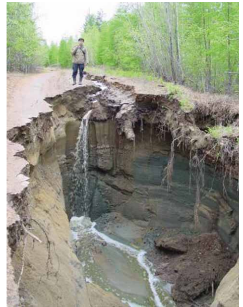
Подобные промоины образуются после оттаивания мерзлотных линз – часть дороги, опиравшейся раньше на ледяную твердь, провалилась, почвы начали вымываться осадками и грунтовыми водами. Биостанция «Спасская Падь» (Якутия), июнь 2007 года
